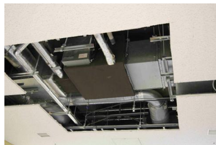
【空調設備の交換】
