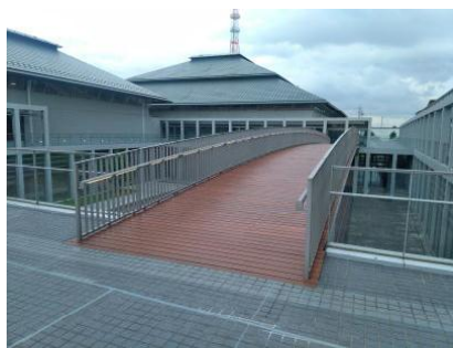
2階ウッドデッキ
