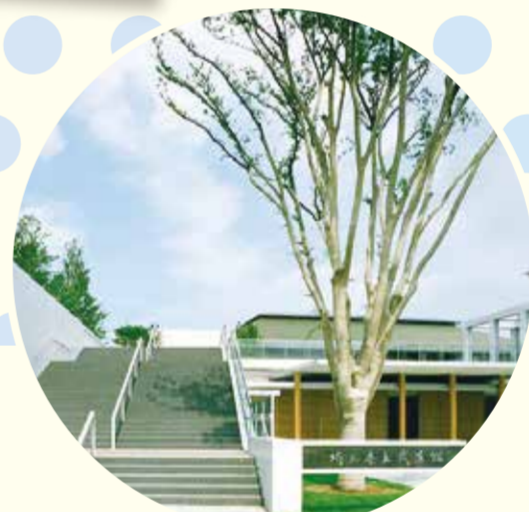
埼玉県立武道館 上尾市日の出4-1877
